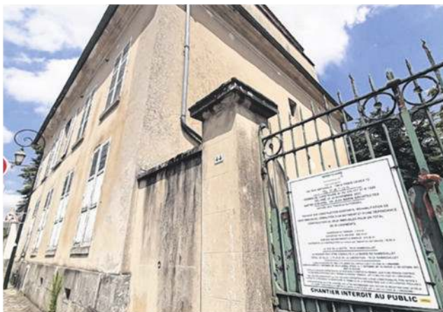
Le bâtiment du 44, rue de La Motte sera transformé en logements.
