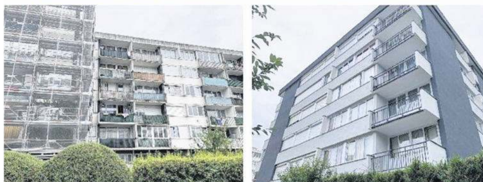
Olivier Klein a échangé sur la réhabilitation des logements au quartier Cocteau dont a bénéficié Mustapha (logement à droite). Un second bâtiment suivra (à g.).
