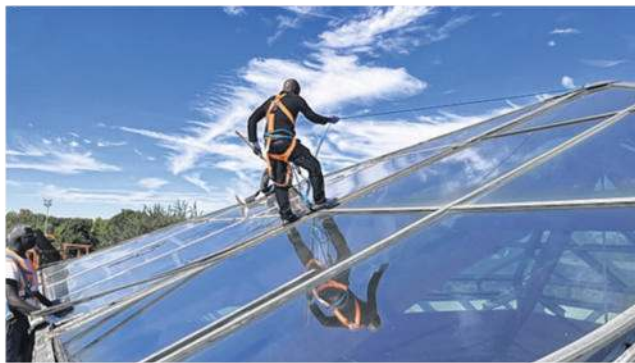
D'importants travaux sur la verrière pyramidale du centre sportif des Pyramides sont en cours.
